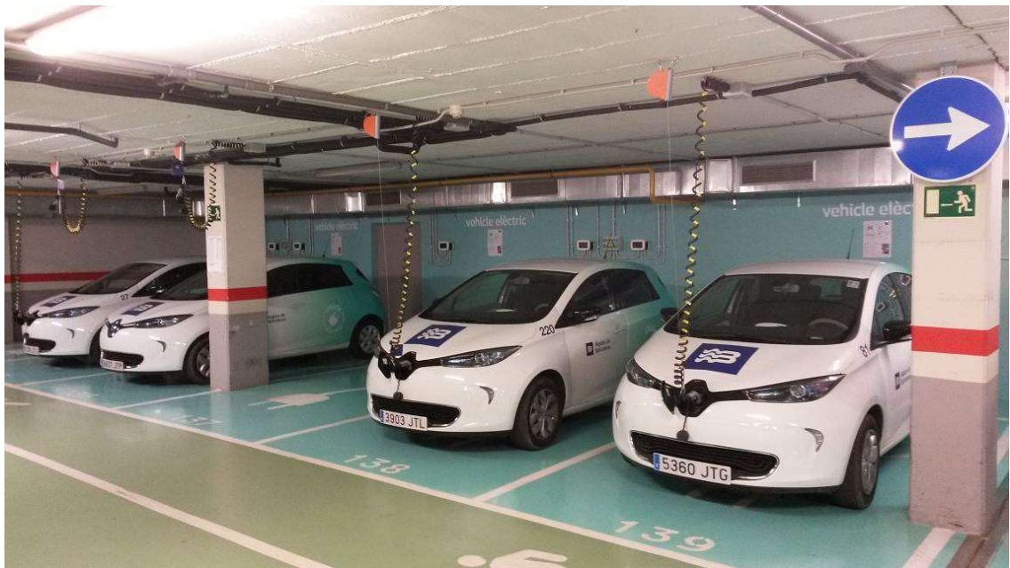
Detall del parking de Collblanc amb sistema de càrrega desde sostre.
