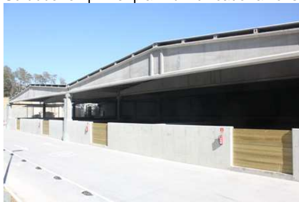
Vista general dels biofiltres.
